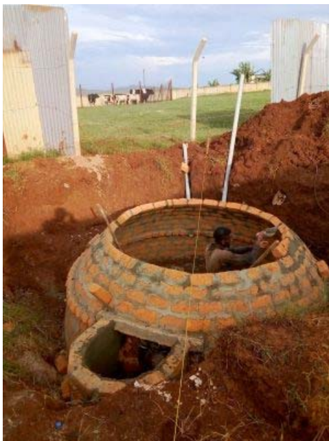
Foto: Bau einer Kleinst-Biogasanlage bei Kakira Sugar Ltd. Dairy Farm, Uganda (Quelle: Kakira Sugar Ltd.)
