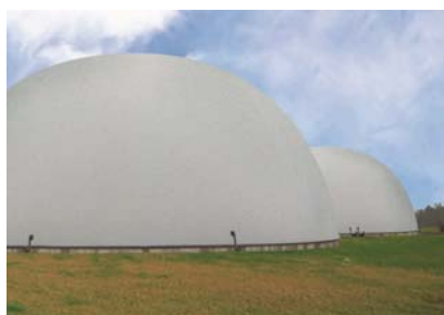
Bild 2: Gasspeicher PlanET eco® gasaku
