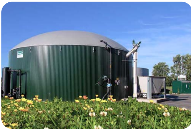
Bild 1: 75 kW Anlage PlanET inkl. PlanET eco® SulfurCat und PlanET eco® smartmix
